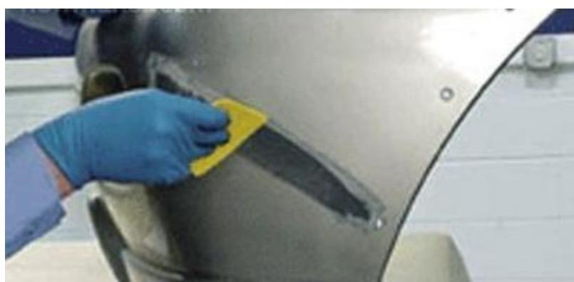
如图 9 所示，如果粘结剂涂抹的有任何缺陷，可将修整用的填料涂抹在已固化的粘结剂上面，进行后整理。
